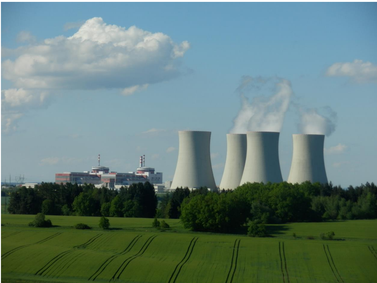
Jaderná elektrárna Temelín, foto Ivan Větvicka, 2013
